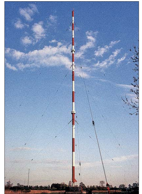
Der 1969 errichtete, 171,5 m hohe Rohrmast des Bayerischen Rundfunks in Ismaning
