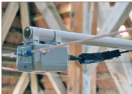
Bild 4: Die Anschlussdosen sind mit Rohrhaltern an den PVC-Rohren befestigt.
