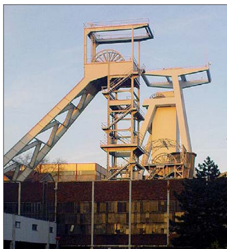
DB0XIT sendet von diesem Förderturm des ehemaligen Bergwerks Götteborn Foto: A. Mühl
