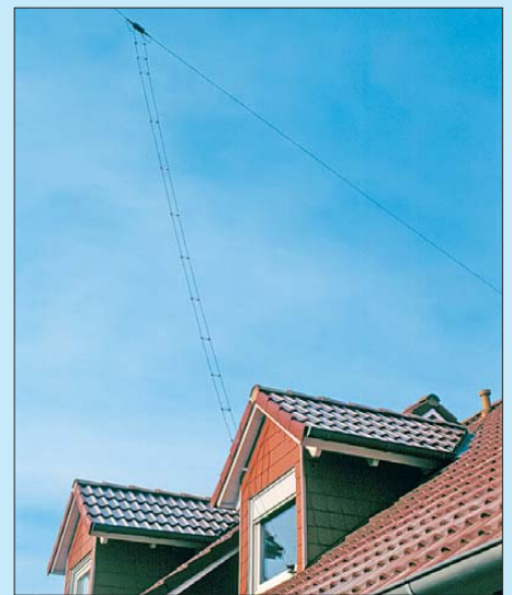
Bild 12: Dipolantenne mit einer „Hühnerleiter“ als Speiseleitung
