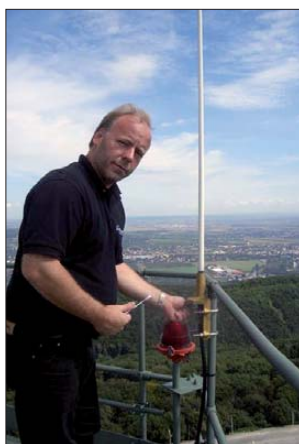
Andreas, OE1BAD, bei der Antennenmontage am Kahlenberg-Umsetzer OE1XUU
