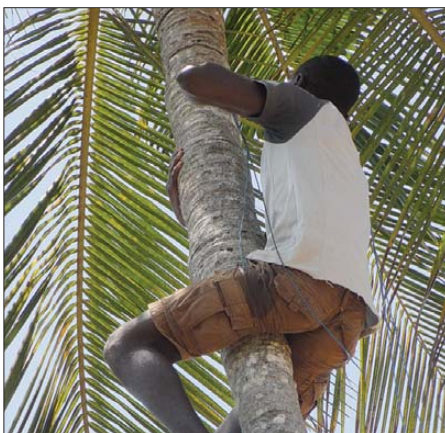
Sportliche Vorkehrungen beim Aufbau der 160-m-Vertikalantenne
