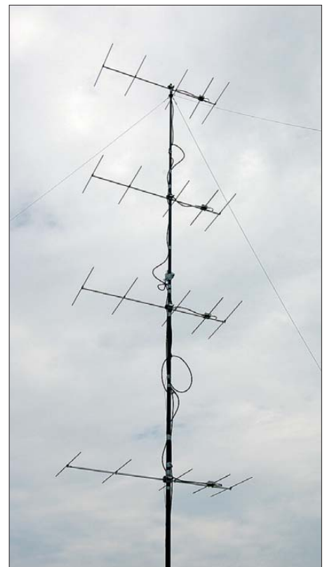
Bild 2: Die 4 × 5-Element-12,5-Ω-Yagigruppe von TM7T
