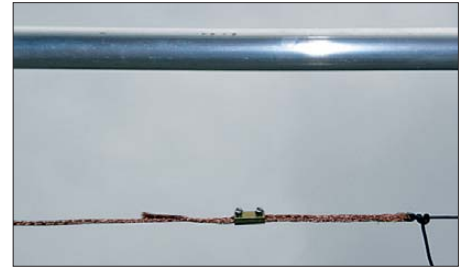
Bild 15: Das Ende der Cu-Litze lässt eine Längenänderung zum Abgleich zu.
