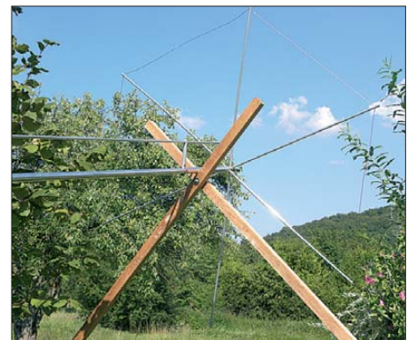
Bild 2: Aufbau der Dachkapazität
