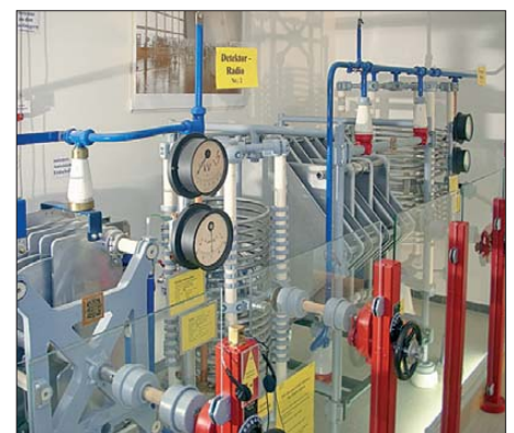
Bild 4: Abstimmereinheit der MW-Sendeantenne für 474 kHz und 500 kHz
