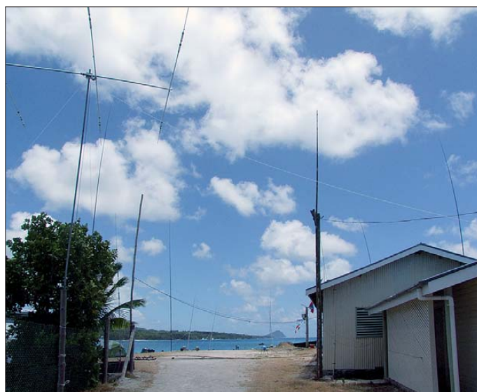
Unsere Antennen waren zum Teil unmittelbar am Landungssteig montiert.
