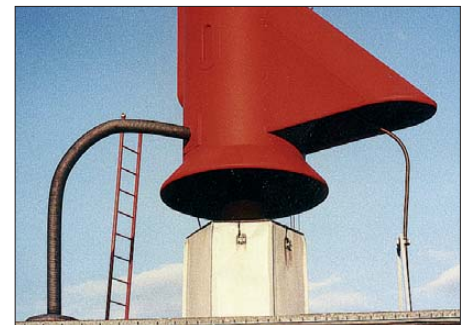
Fußpunktisolator des Rohrmastes (1998)
