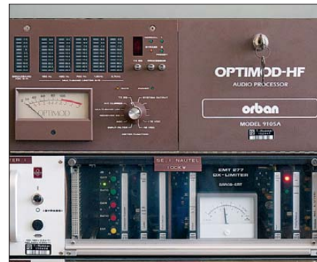
Limitier und Optimod für den MW-Sender Ismaning
