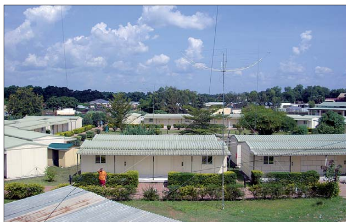
Ansicht vom Wassertank des Hotels auf einen Teil unserer Antennenfarm
