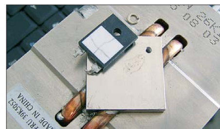
Bild 4: Defekter Widerstand auf einem Kühlkörper mit Strommarken Fotos: DL7LA
